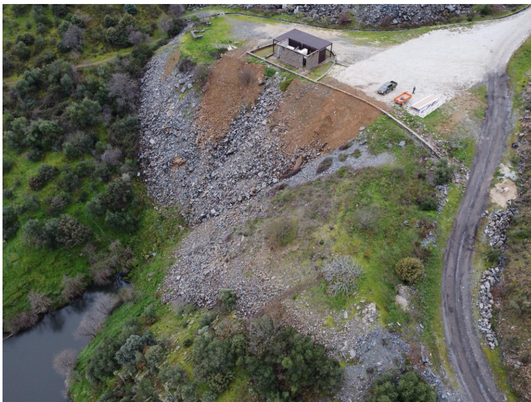
Fig. 2: Escombrela após deposição de materiais (09/01/2024).
