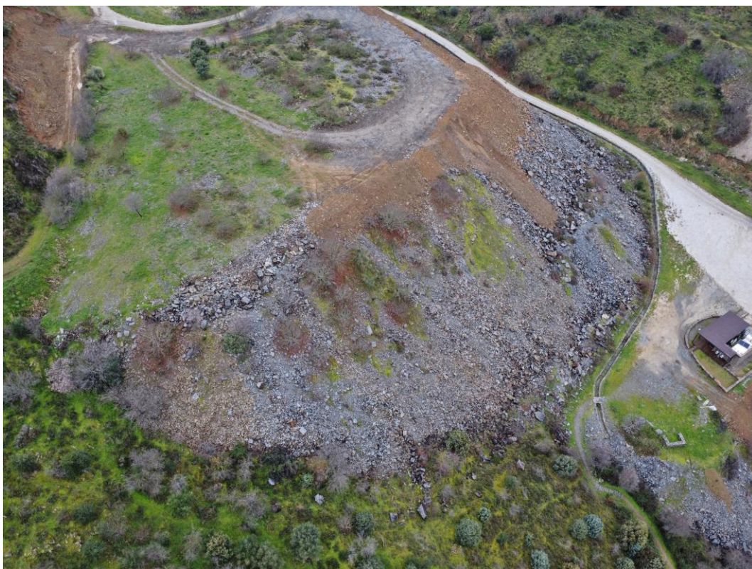
Fig. 3: Escombeira após deposição de materiais (09/01/2024).
