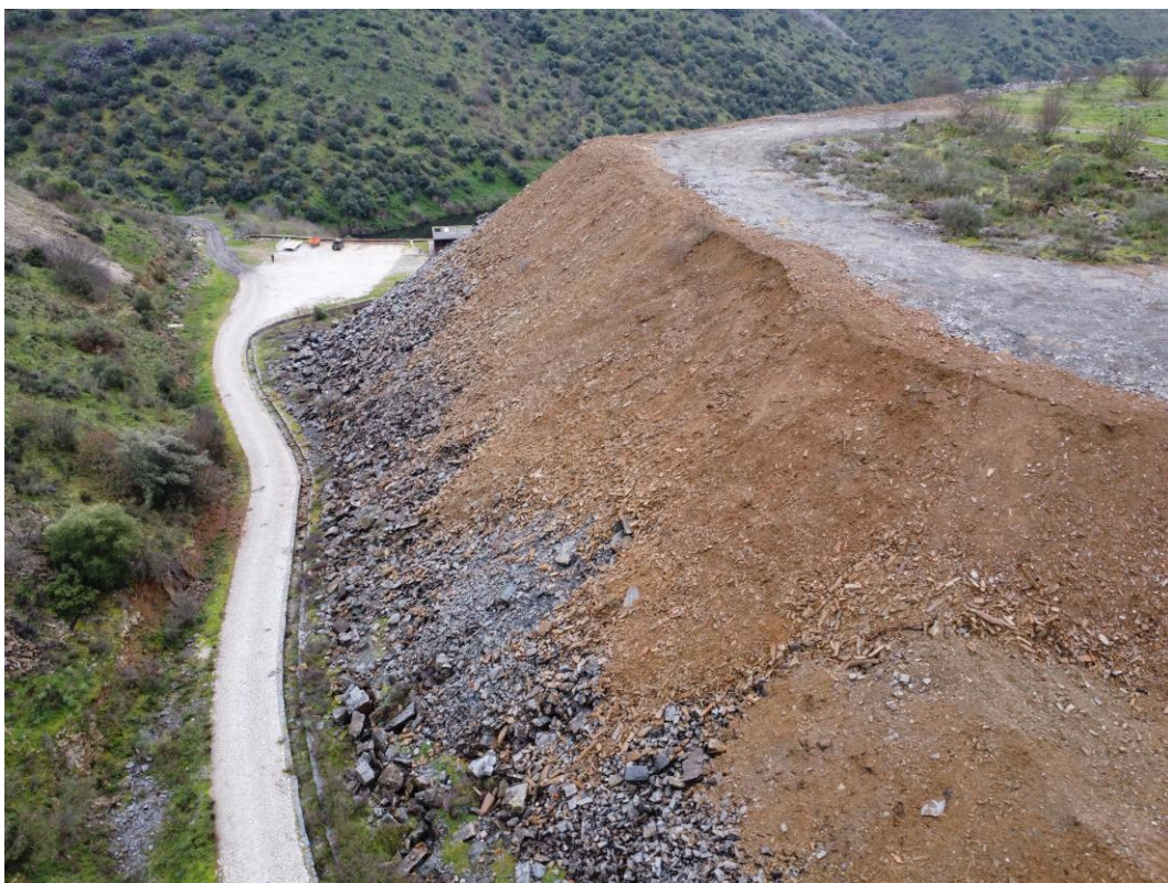
Fig. 4: Escombeira após deposição de materiais (09/01/2024).
