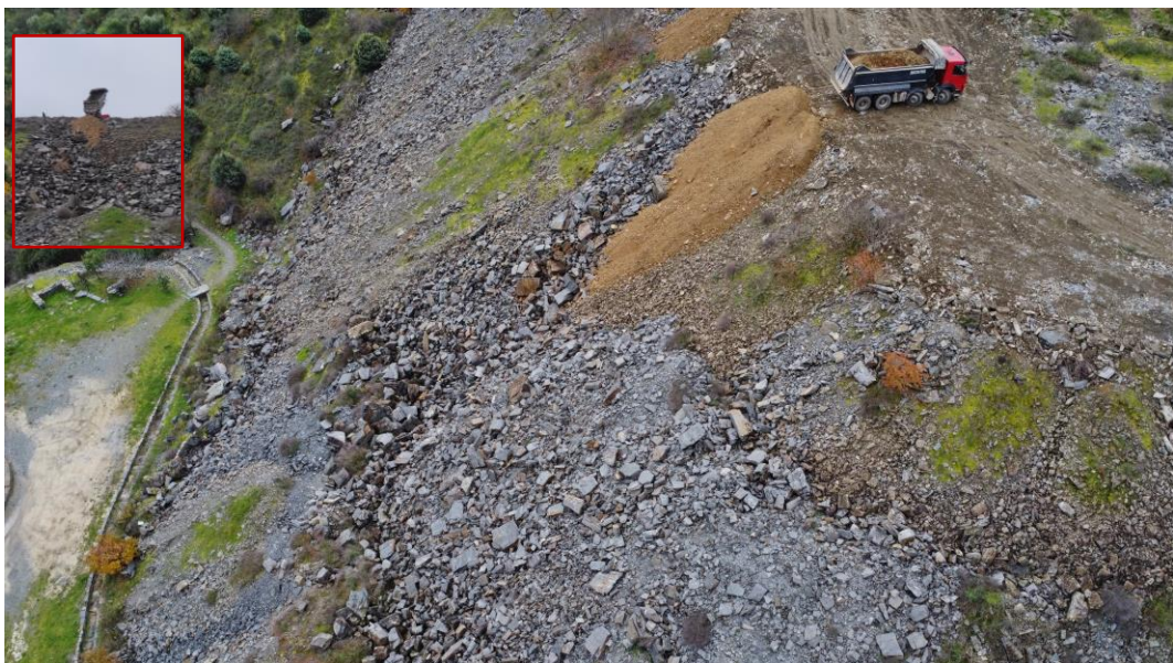
Fig. 4: Deposição do material na face do talude (20/12/2023).
