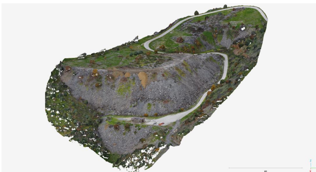
Fig. 6: Área de inspeção no dia 20/12/2023.
