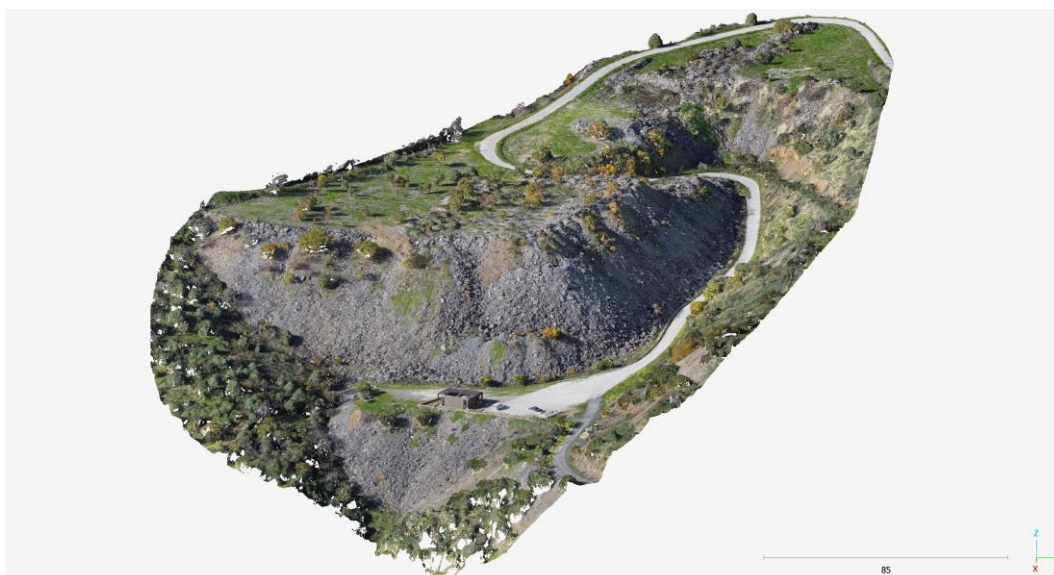
Fig. 5: Área de inspeção no dia 22/11/2023.
