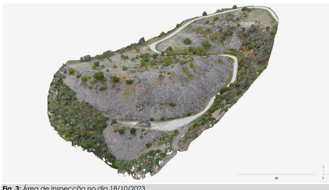
Fig. 3: Área de inspecção no dia 18/10/2023.
