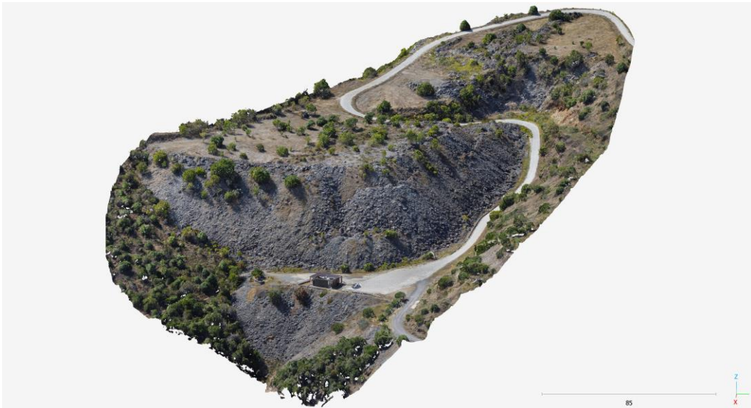
Fig. 4: Área de inspeção no dia 12/09/2023.
