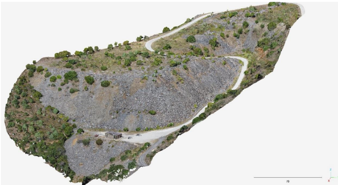
Fig. 13: Área de inspeção no dia 31/07/2023.
