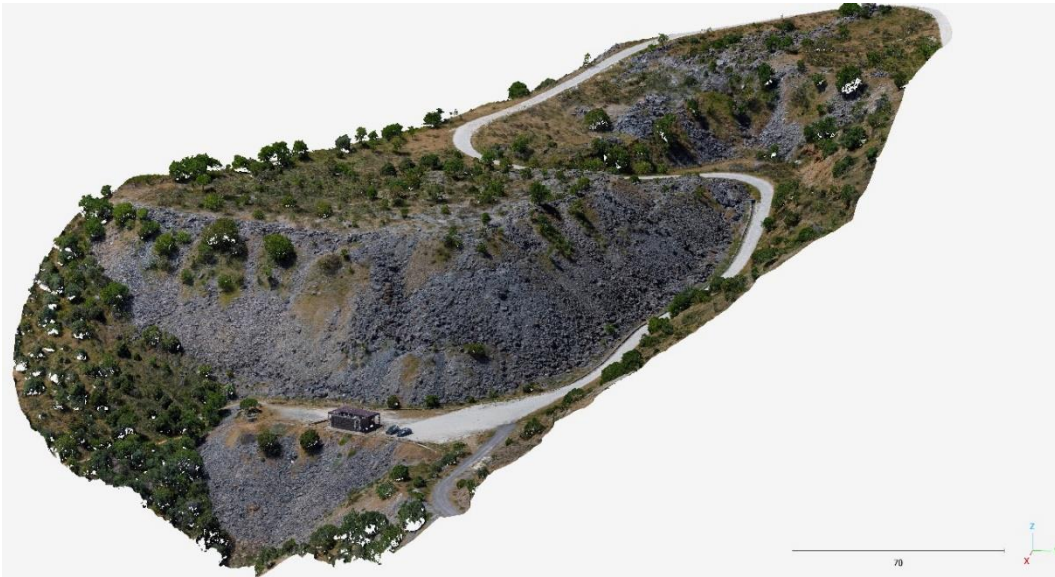
Fig. 8: Área de inspeção no dia 18/04/2023.
