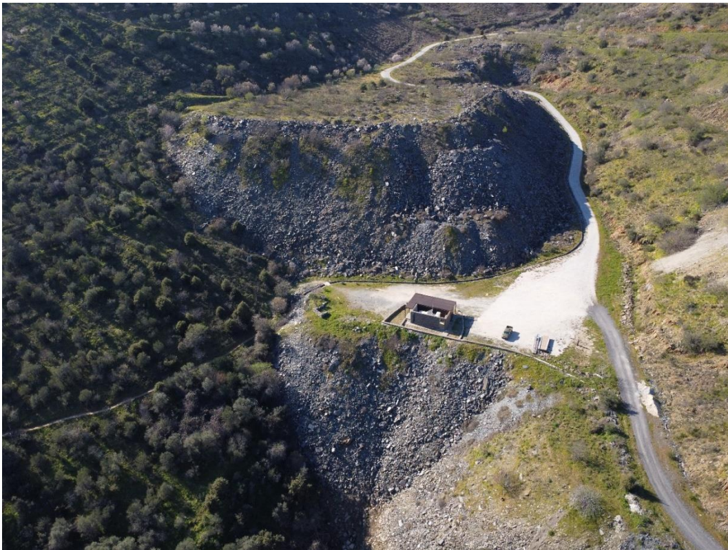
Fig. 5: Fotografia aérea da área da escombreira (17/02/2023).
